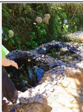
Construcción de Biojardinera para tratar las aguas de desechos de lavado con comida del restaurante y siembra de árboles, mantenimiento de jardines y senderos
